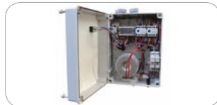
22 Cuadro eléctrico para motor cajón estanco Quadro elétrico para caixa de apertado Motor
