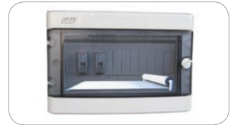
16 Cuadro eléctrico para cubierta exterior Quadro elétrico para cobertura exterior
