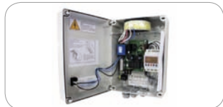
21 Cuadro eléctrico para motor tubular cubierta sumergida Quadro elétrico para motor tubular cobertura submersa
